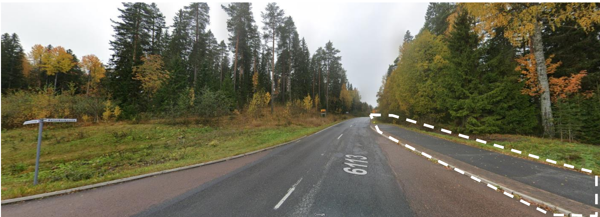
Kuva 1, Kaijanlammentien risteyksestä etelään, päättyvä nykyinen pyörätie oikeassa reunassa.
