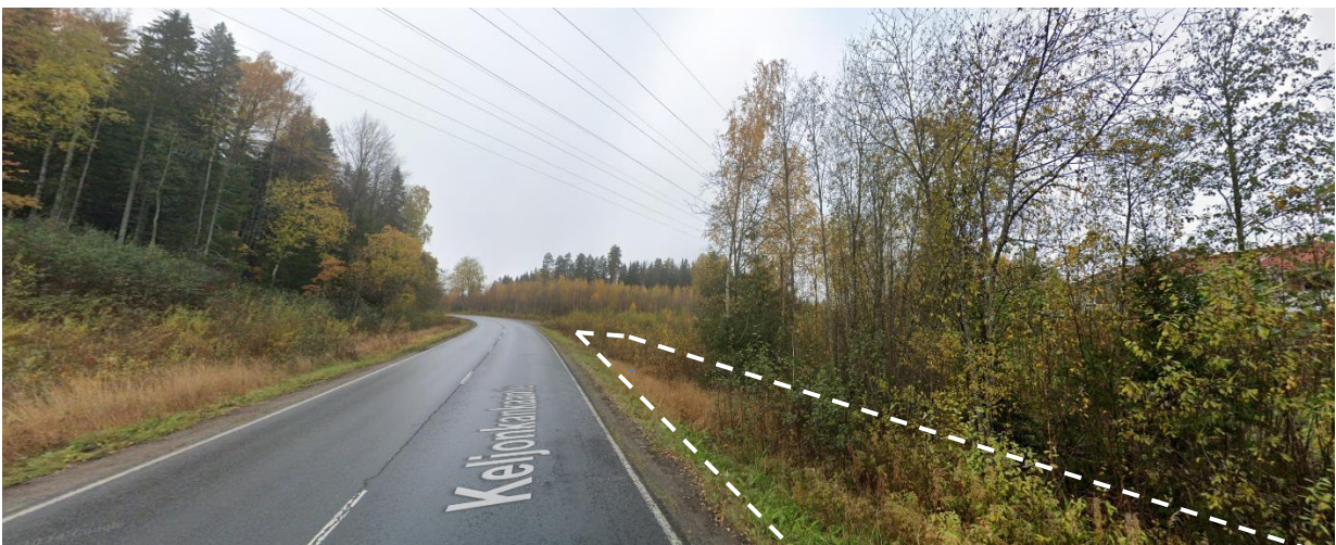
Kuva 2, Keljonkankaantie voimalinjan kohdalta etelään. Pyörätien linjaus valkoisella oikeassa reunassa.
